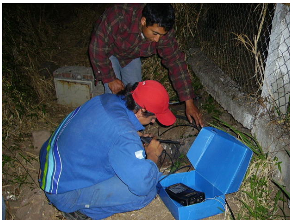
Ej. Asistencia en la colocación de equipos
